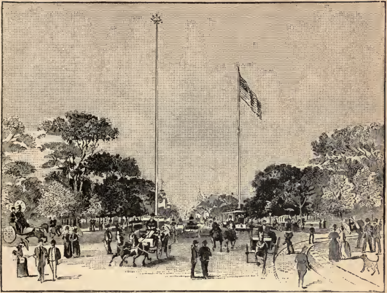
VISTA DE LA CALLE SUPERIOR Y LA "PUBLIC SQUARE"—Cleveland.
